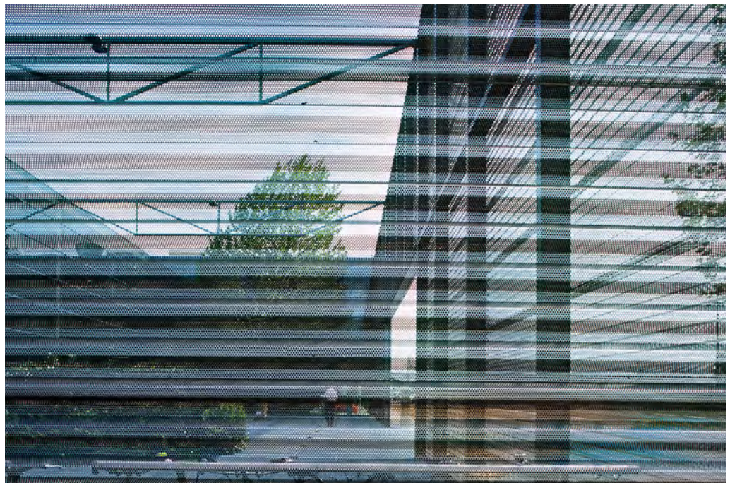
Na letišti Charlese de Gaulla v Paříži vytvářejí lichoběžníkově profi- lované ocelové plechy s děrováním průměru 68 mm venkovní odstí- nění interiéru prosklené odletové haly.
